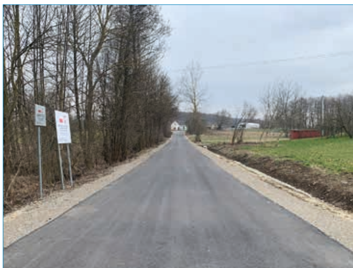
Rozbudowana droga gminna Nowa Wieś – Julianów.
