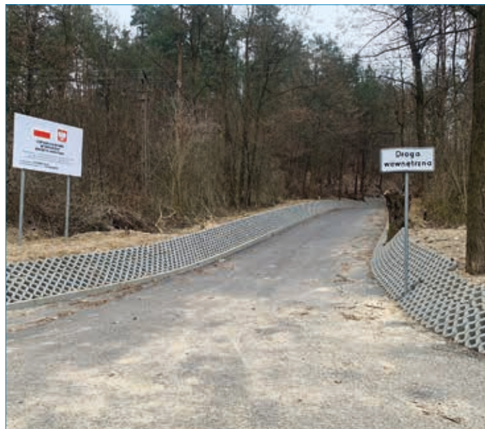
Zabezpieczone dno wąwozu lessowego w ciągu drogi wewnętrznej w Rybnicy.
