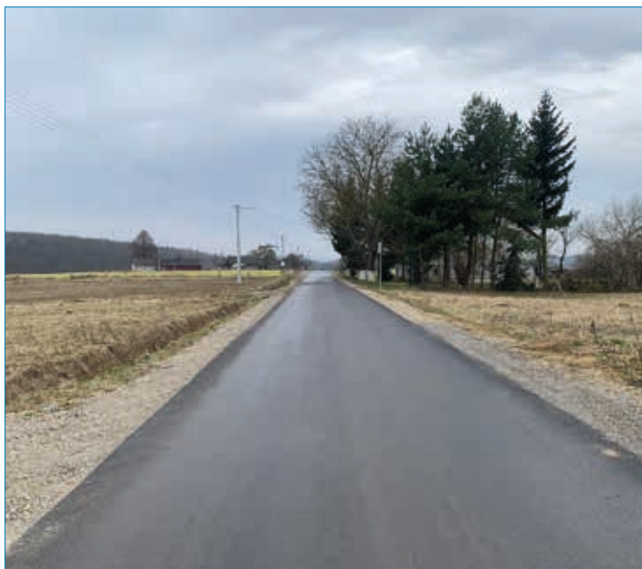
Wybudowana droga gminna Beradz-Kolonia Łownica.
